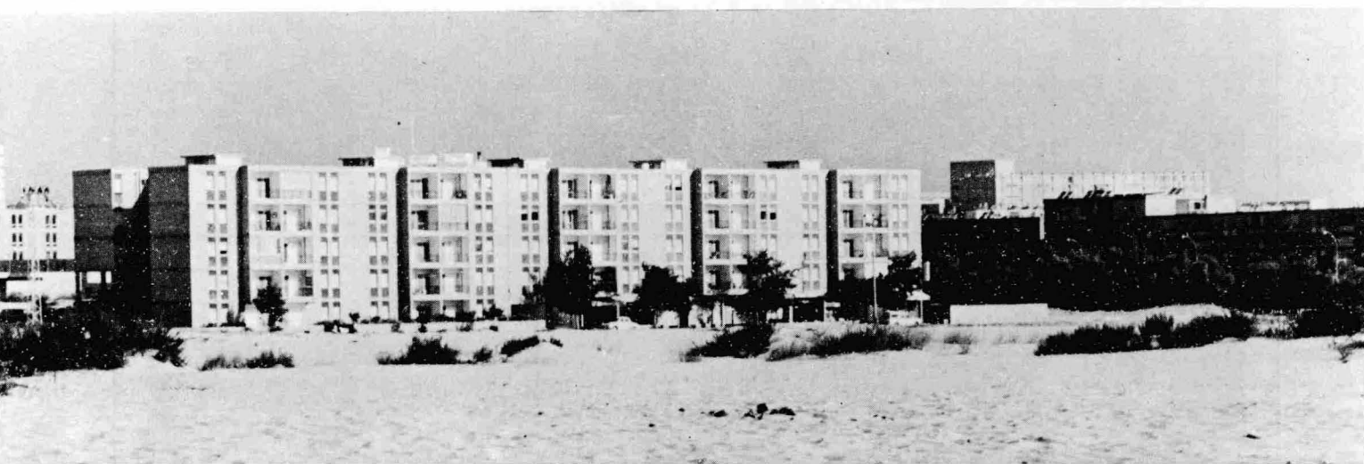
Casas da nova cidade construída em Ashdod, Israel. "A maioria dos países em desenvolvimento julga hoje conveniente formular planos de desenvolvimento que abranjam vários anos..."
