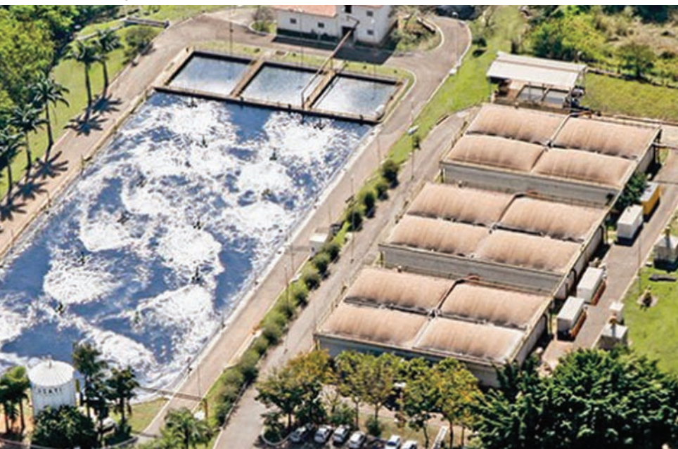
Estação de tratamento de esgoto da concessionária Águas do Mirante, em Piracicaba/SP: participação da iniciativa privada no saneamento ainda é baixa, de 6% do total
